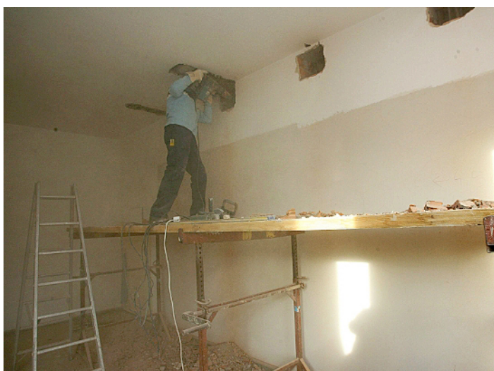
Vollen Körpereinsatz bewies der Bauarbeiter beim Durchbrechen der Wand. Dabei wurde jede Menge Staub aufgewirbelt. Foto: Barbara Herbst
